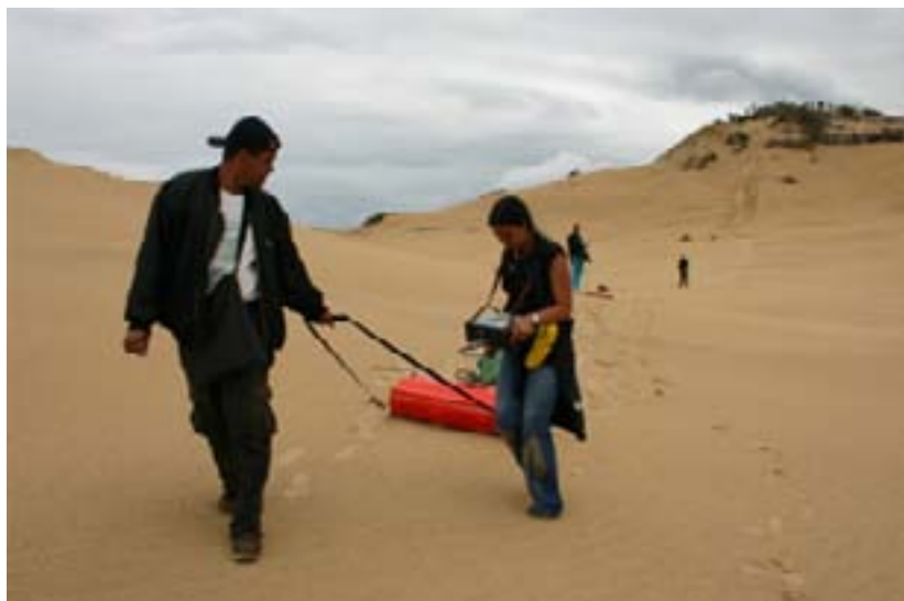
Levantamento com Radar de Penetração de Solo (GPR) para a investigação do subsolo.
