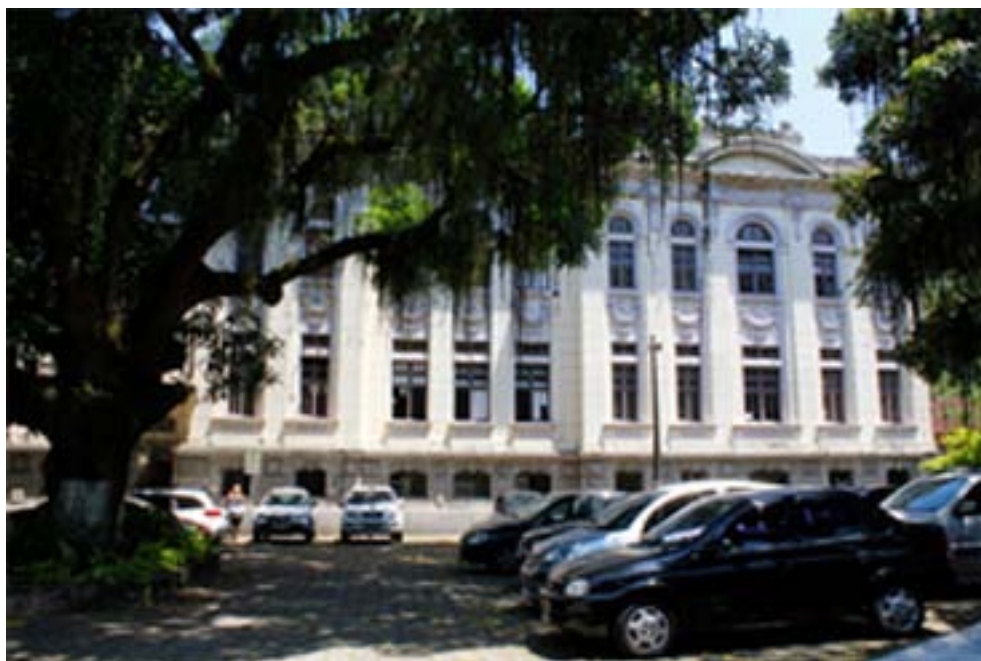
Prédio do Departamento de Engenharia de Minas e de Petróleo da Escola Politécnica – Santos - SP
